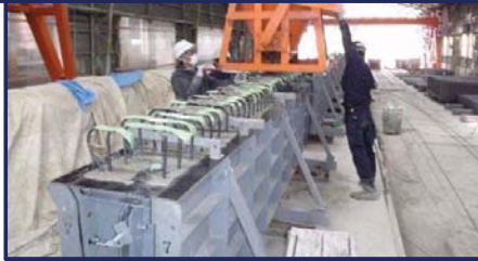
プレキャスト壁高欄の製作(JIS 工場)
