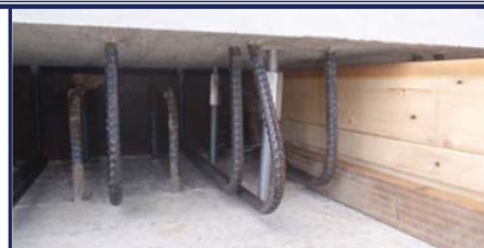
プレキャスト壁高欄の高さ調整
