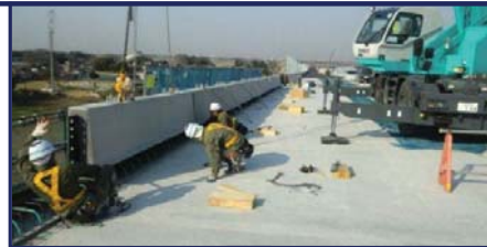
プレキャスト壁高欄のブロック建込み
