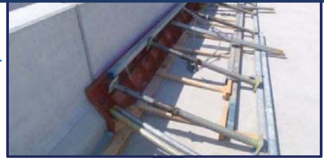
高耐久無収縮モルタル充填部の型枠設置
