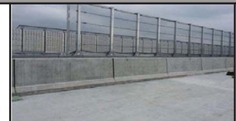
プレキャスト壁高欄の完成
