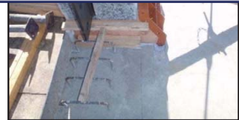
高耐久無収縮モルタルの充填
