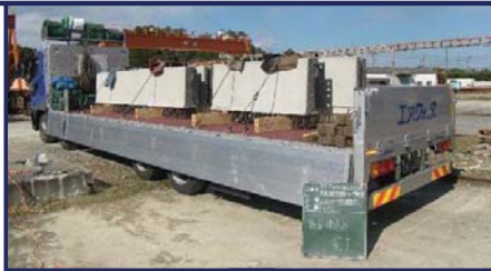
プレキャスト壁高欄の運搬・現場搬入
