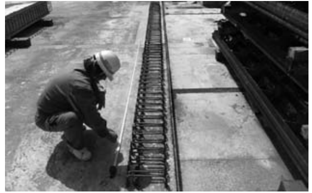
写真-6 鉄筋の組みあがり配置
