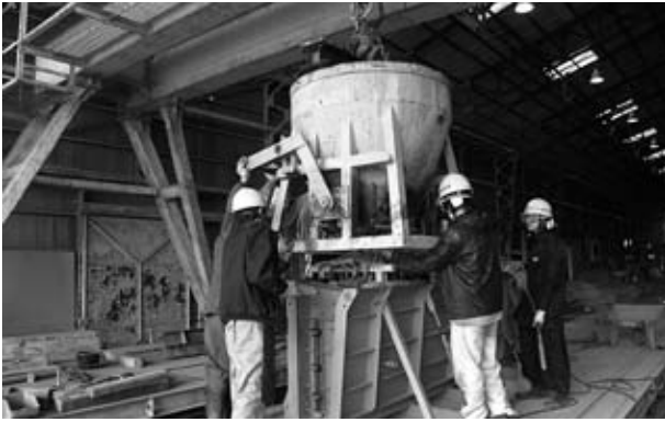
写真-3 コンクリート打設
