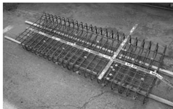
写真-2 鉄筋のユニット化
