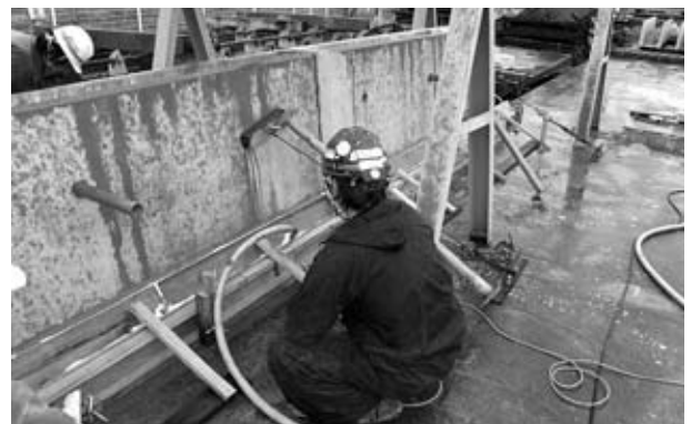
写真-8 無収縮モルタル注入状況
