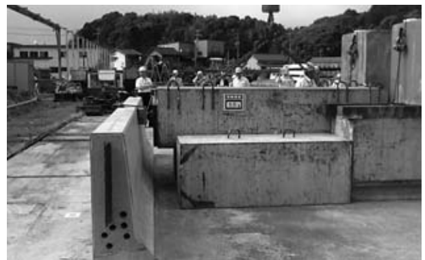
写真-10 重錘配置状況
