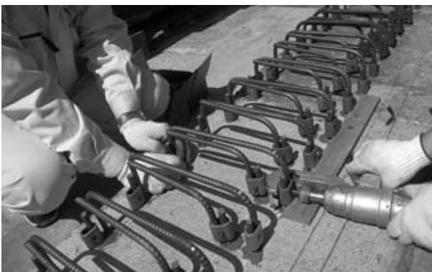
写真-5 OSフープグリップを用いた鉄筋の配置
