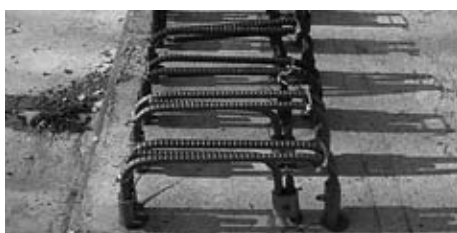
写真-1 既設床版と壁高欄の接合部鉄筋配置
