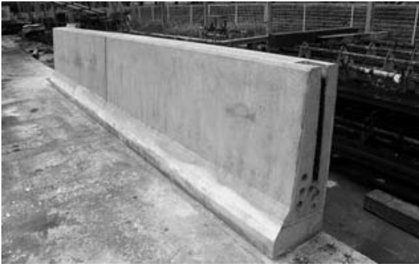
写真-9 完成状況
