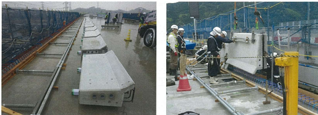
写真-1 橋面上仮置き状況/写真-2 建込状況
