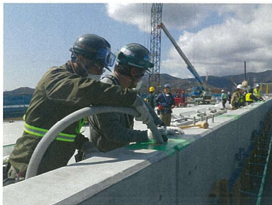
写真-5 接合モルタル充填状況／写真-6 型枠脱型後の完成状況
