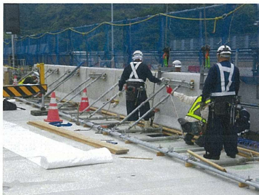
写真-3 建込後の仮固定状況/写真-4 モルタル充填用型枠設置状況
