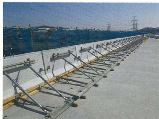
写真-3 建込後の仮固定状況/写真-4 モルタル充填用型枠設置状況
